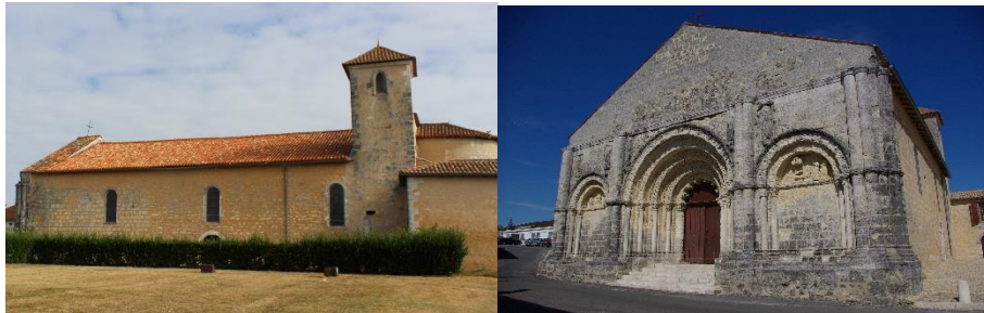
Façade sud et portail sculpté de l'Église Saint Martial Source : Atelier du Périscope / Wikipedia
