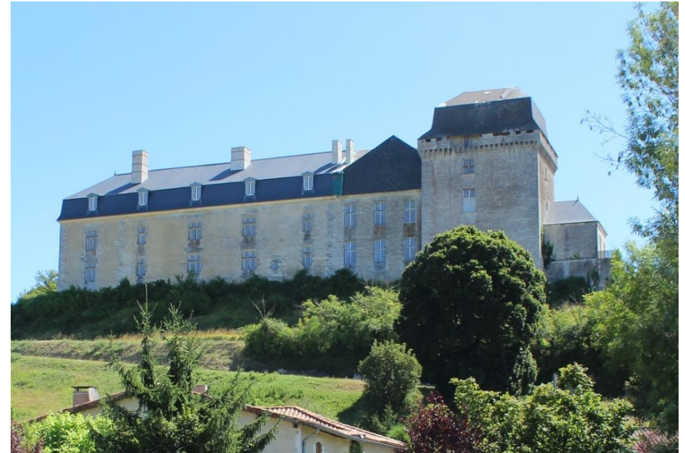
Le château depuis l'entrée ouest de Chalais.
