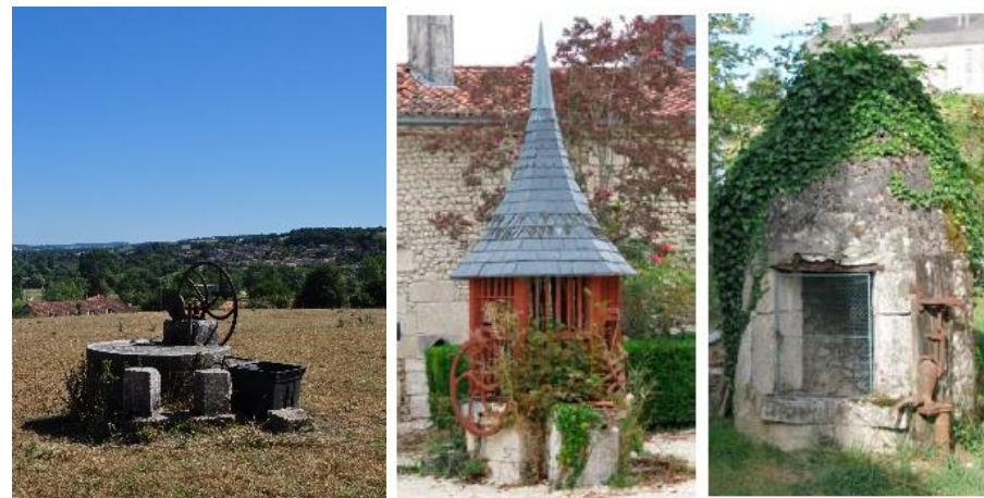
Puits de Sérignac / Puits lieu dit Farziou / Puits impasse de Blanzac Source : inventaire.poitou-charentes.fr
