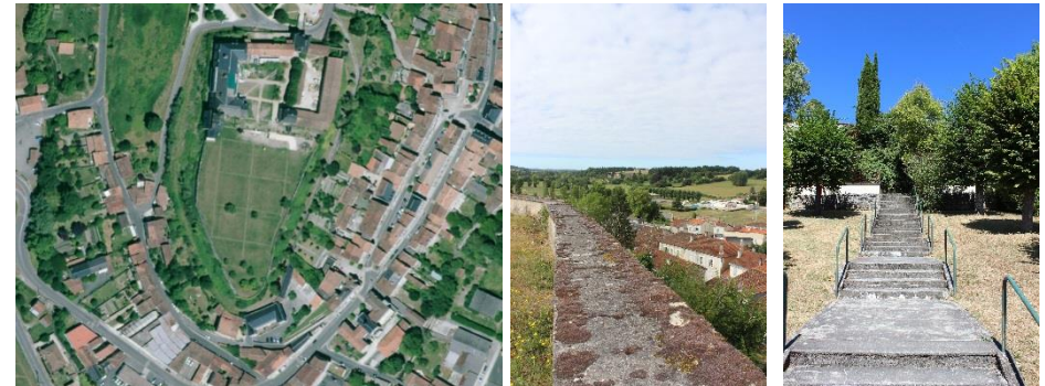
Mur de soutènement du château / Escalier menant à la promenade des remparts Source : Atelier du Périscope
