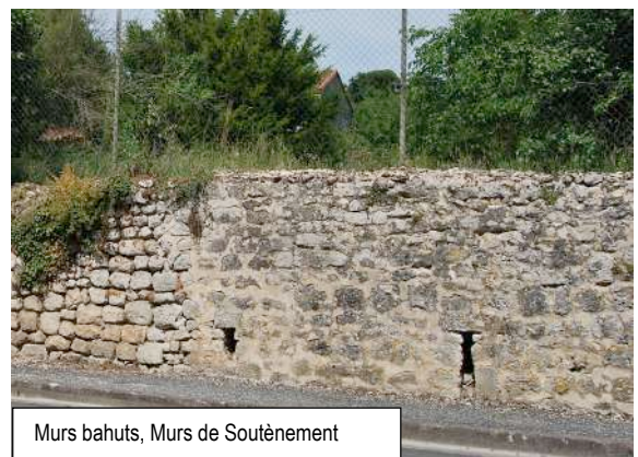
Murs de soutènement
