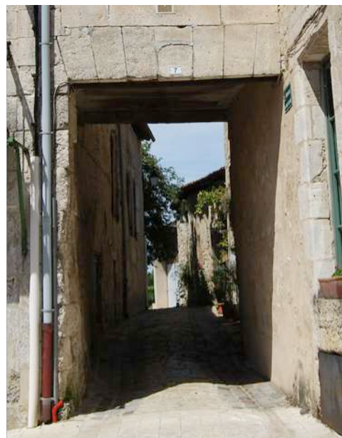
Exemple de linteau en plate-bande
