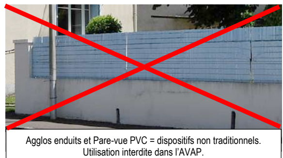
Murs bahuts, Murs de Soutènement
