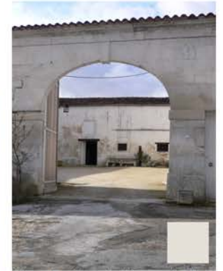
Vaux-Rouillac, badigeon de chaux
