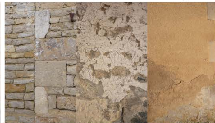
Détail de maçonnerie
