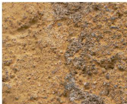
Restauration d'enduit et détail
