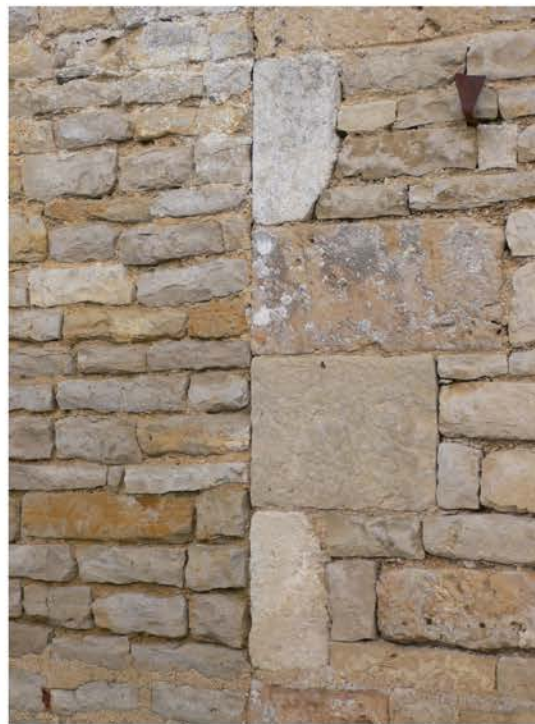
Moellons calcaires équarris, assisés et chaînage
