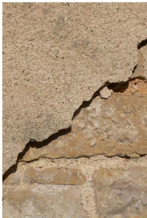
Maçonnerie de moellons jointés et enduits
