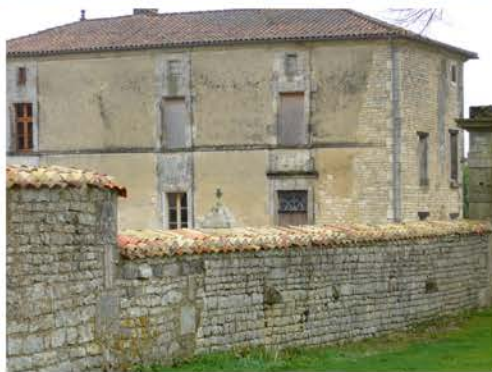
Moellons calcaires équarris et assisés
