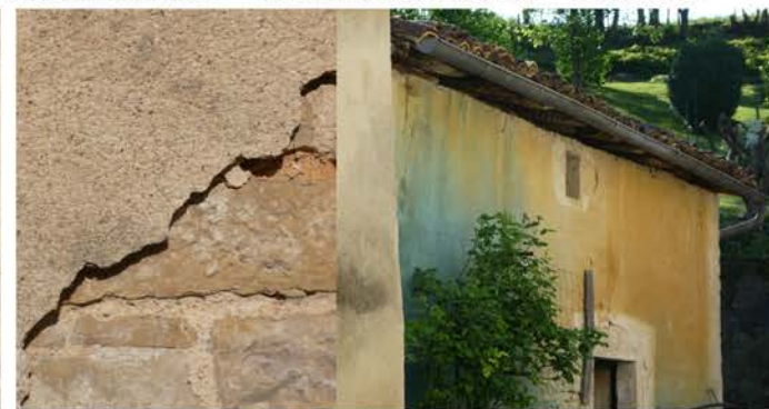
Maçonnerie jointée puis enduite
