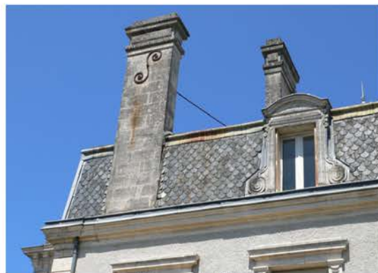
Toiture en ardoise
