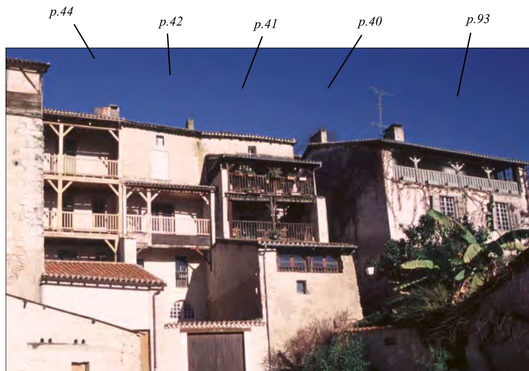
Place Merkès-Merval ou place Barbecane. Parcelle 93 : galerie en loggia sous toiture, parcelles 40 & 41 : galeries-balcons en saillie, et parcelle 42 : galerie en loggia. Complètement à droite, une galerie attique semble avoir été fermée (parcelle 44).
