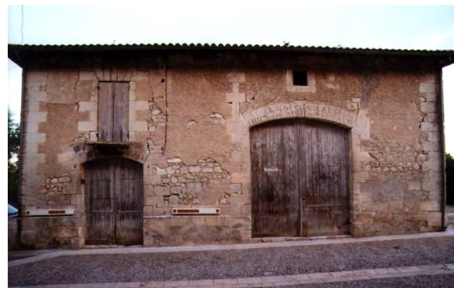
Atelier, Parcelle 238, à l'angle des rues Saint Jean et Bardichon. Atelier avec portes en arc segmentaire.
