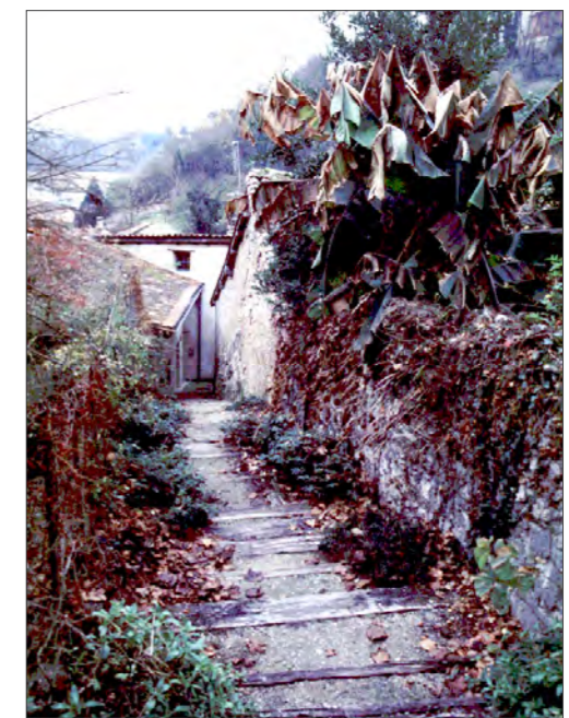
Traverses de bois stabilisant un cheminement reliant la rue Barbecane à la rue Saint Jean.
