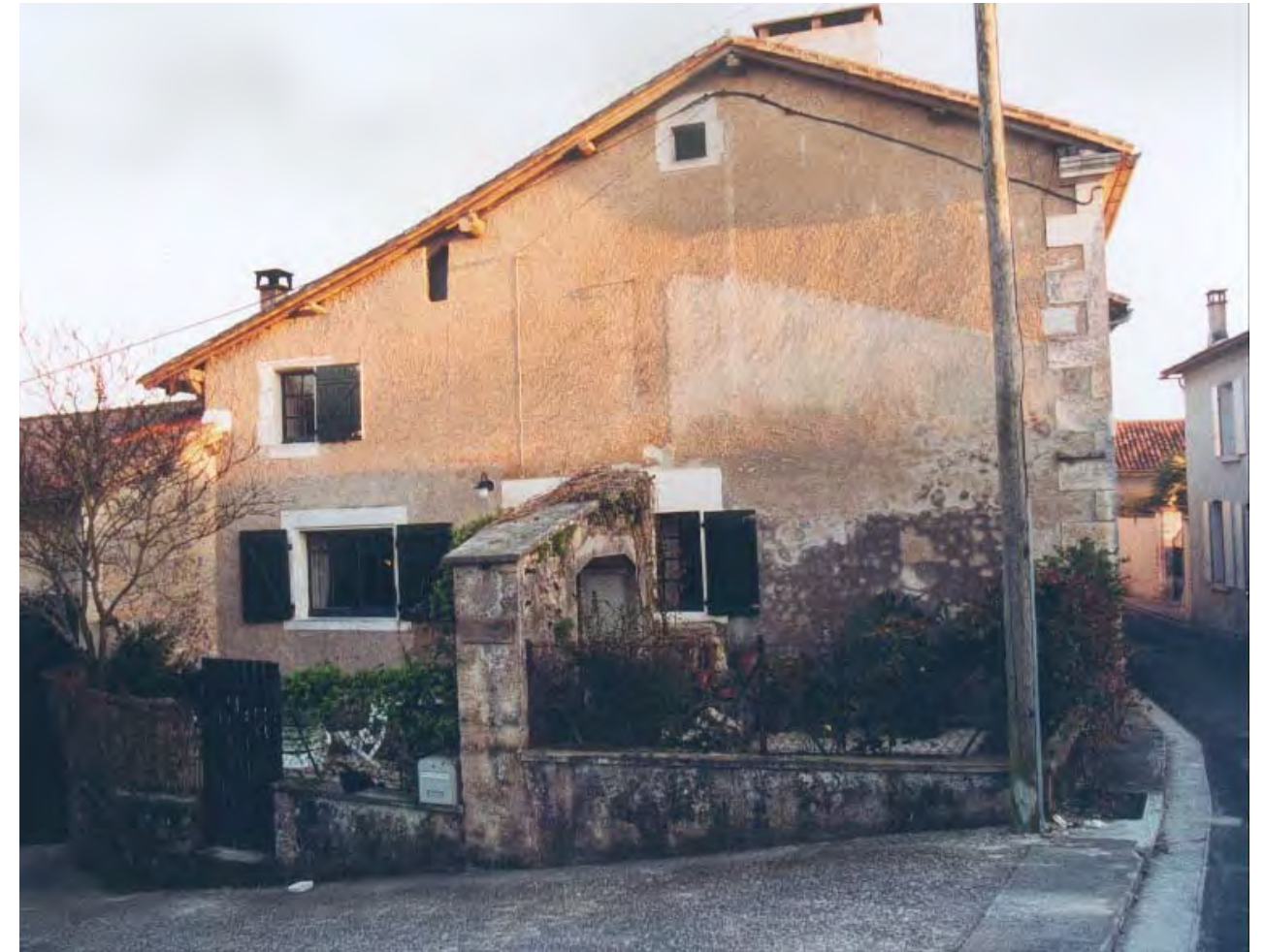
Parcelle 298, à l'angle de la rue Moignard et du Chemin Creux. Cette maison est appuyée contre une construction mitoyenne et ne possède donc qu'une façade. En alignement sur la Moignard, elle s'ouvre sur son pignon sur le petit Chemin Creux. On remarque l'empreinte sur le mur d'une ancienne construction, cette partie devait alors venir jusqu'au mur de refend encore présent dans le jardin. Dans son axe, un puits a été fermé.
