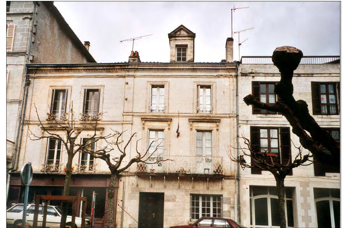
Place Trarieux. Façades parcelles 497 & 487, avec éléments décoratifs et balcons.
