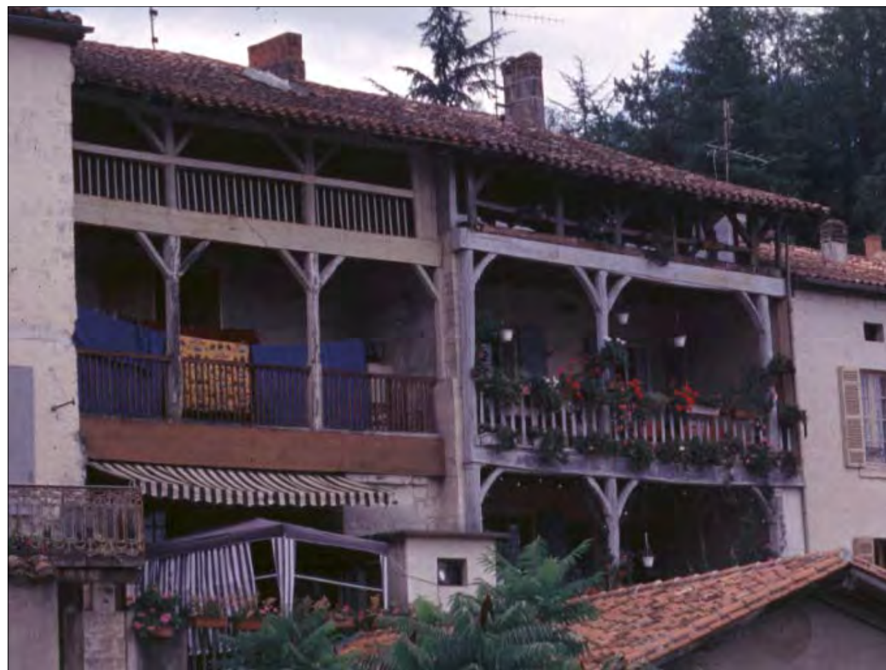
Parcelles 47 & 48, côté Rue Barbecane. Galeries anciennes en loggia.
