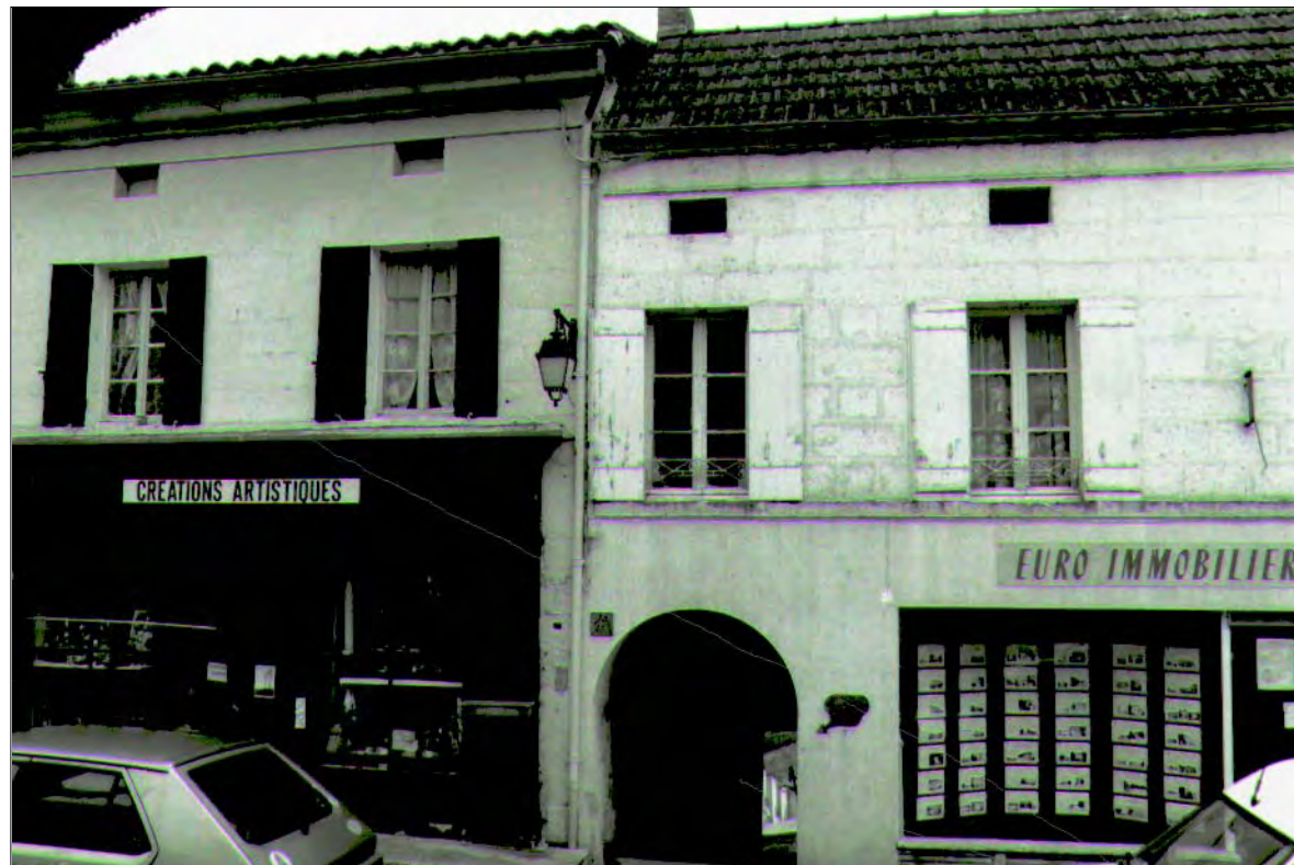
Parcelles 44 & 46, place Ludovic Trarieux. Le bandeau remplace l'appui de fenêtre. L'étage attique est surmonté d'une corniche à ressauts.
