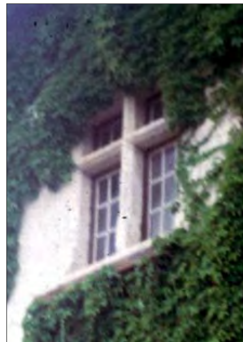
Fenêtre à double meneaux, rue Saint Jean.
