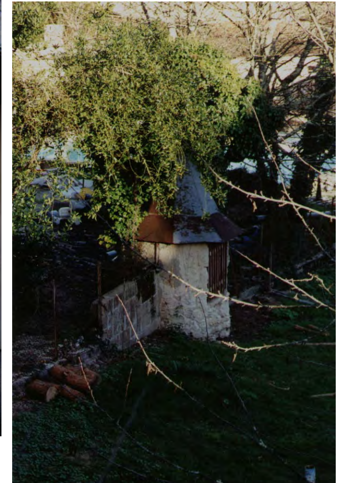
Parcelle 142, rue Véry. Puits couvert d'un « chapeau de sorcière » métallique.
