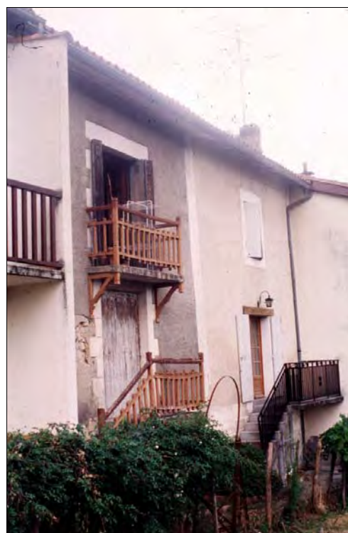
Parcelles 59 & 60, rue Saint Jean côté route de Laprade. Influence sur les balcons en bois, lointains dérivés des ouvrages des galeries.
