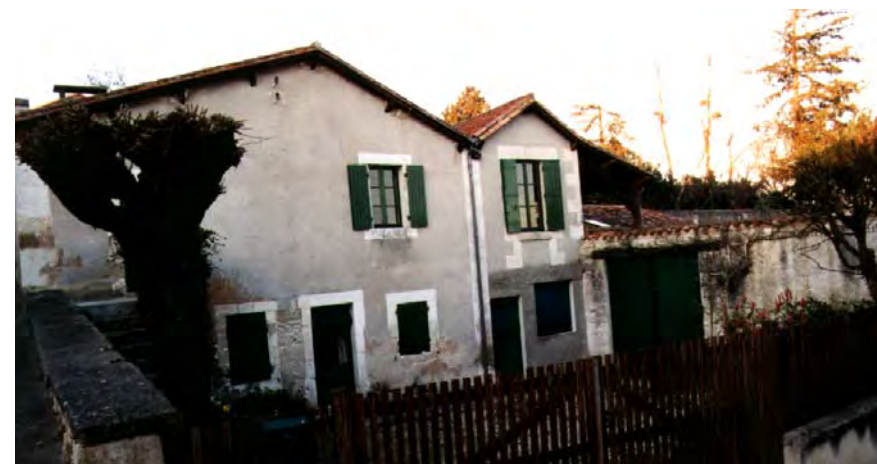
Parcelle 282, Chemin Creux. Exemple de maison du début du XX° siècle.
