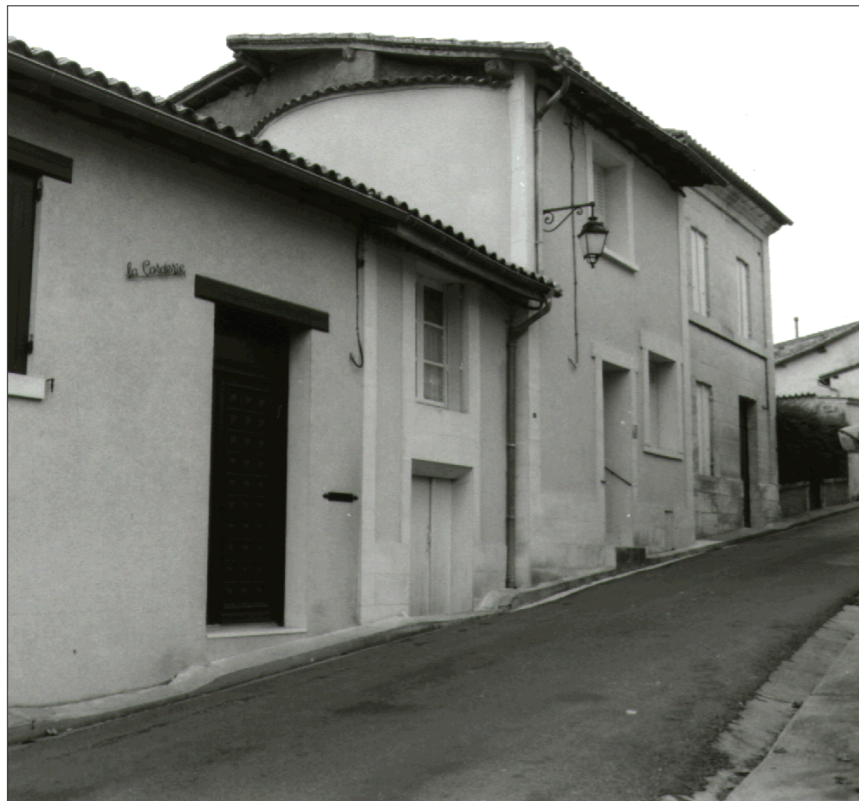
Vestige d'une tour probablement de la Porte de la Marche , située dans la Grand rue, parcelle 270
