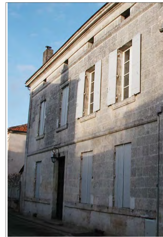
Rue Véry, parcelle 411, façade en pierres de taille régulières atteste un bâti fin du XIX ème siècle. La porte et la baie de la travée centrale présentent des encadrements moulurés un étage attique
