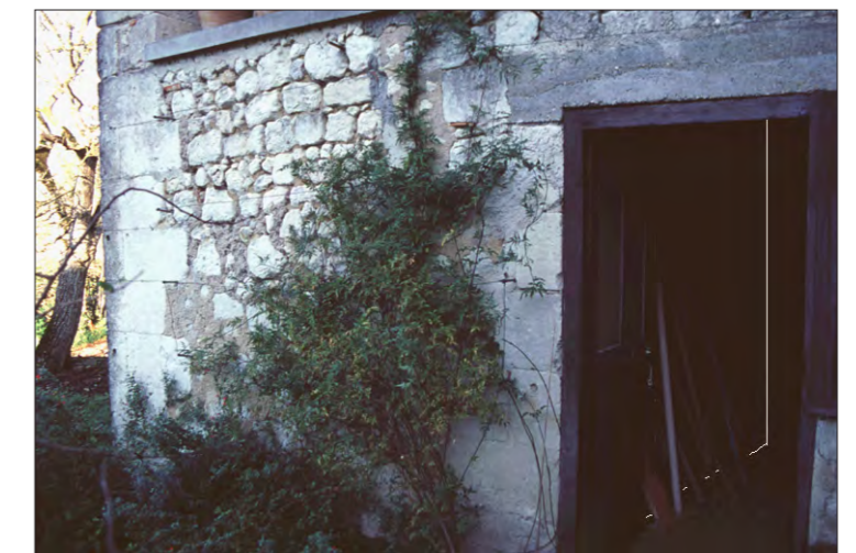
Vestige du mur de fortification dans une construction annexe de la parcelle 221, rue Véry (mur de plus de 3 mètre d'épaisseur)
