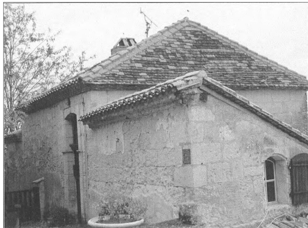
rue Bardichon: exemple de toiture à quatre pentes, avec tuiles creuses pour les longs pans et tuiles plates pour les croupes.
