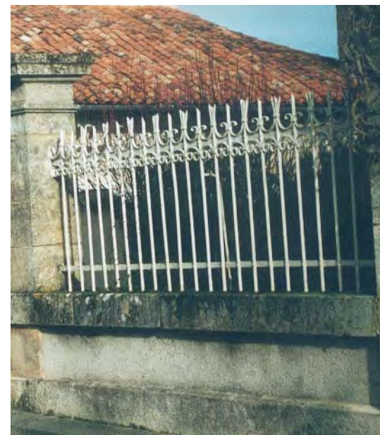
Parcelle 137, rue Véry. Muret de pierres et grille
