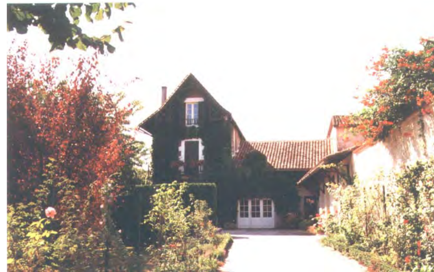
Parcelle 111, rue St Jacques, vue depuis le portail d'entrée.
