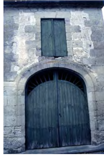
Parcelle 234, rue Véry. Porte en anse de panier.
