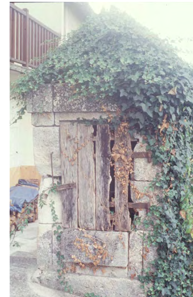
Puits fermé, rue Bardichon.
