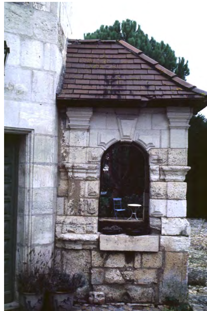
Parcelle 471, impasse de l'église Saint Jacques. Puits remanié, adossé à la tour des Apôtres.
