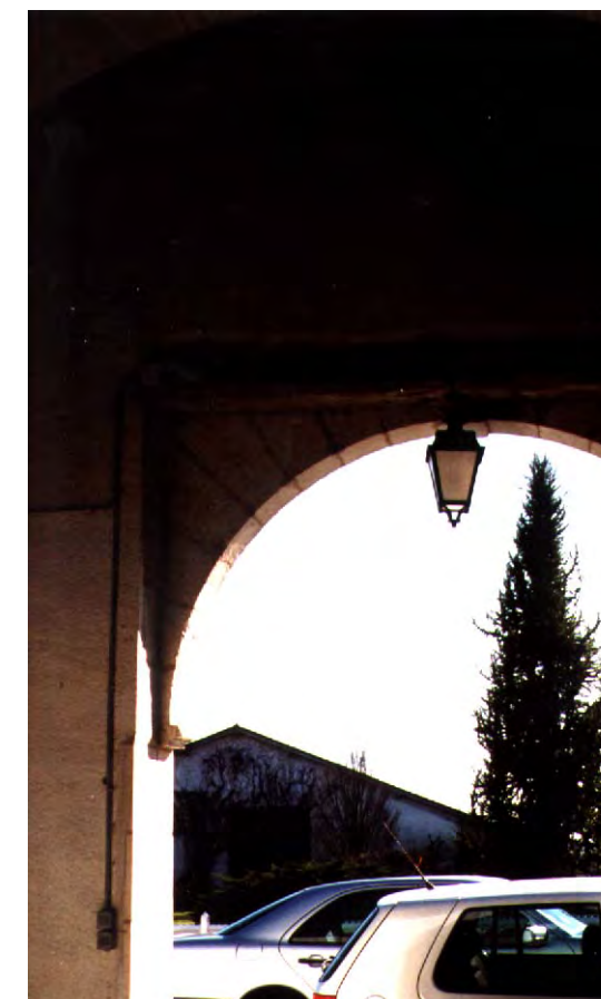
Baise-Vigne, chai viticole. Linteau de porte en pierres et en arc plein en façade. A l'intérieur, le linteau est doublé d'une poutre de bois, les vantaux de la porte sont rectangulaires et viennent prendre place dans la feuillure du mur.
