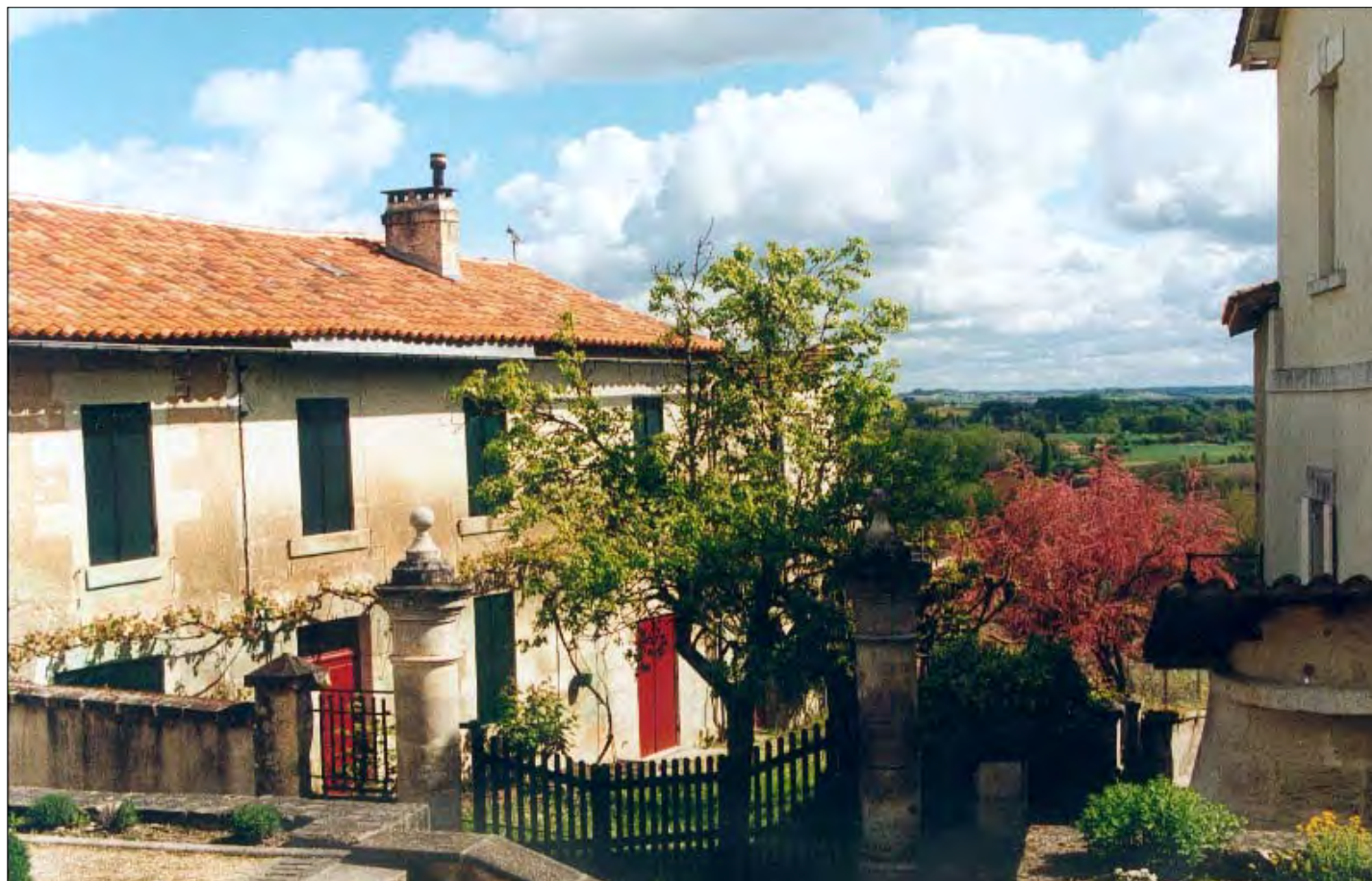
Parcelle 140 chemin de l'Hôpital Saint-françois. Maison à caractère rural.
