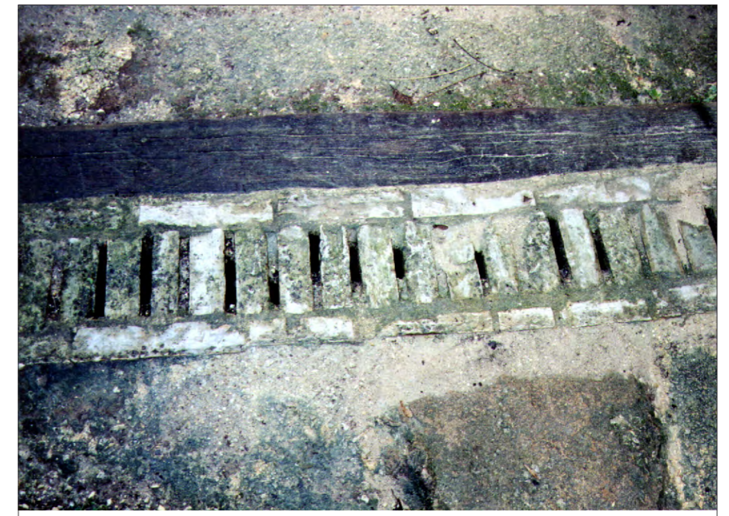
M o d è l e s d'emmarchement et de traverses employés à Aubeterre dans les cheminements pentus.
