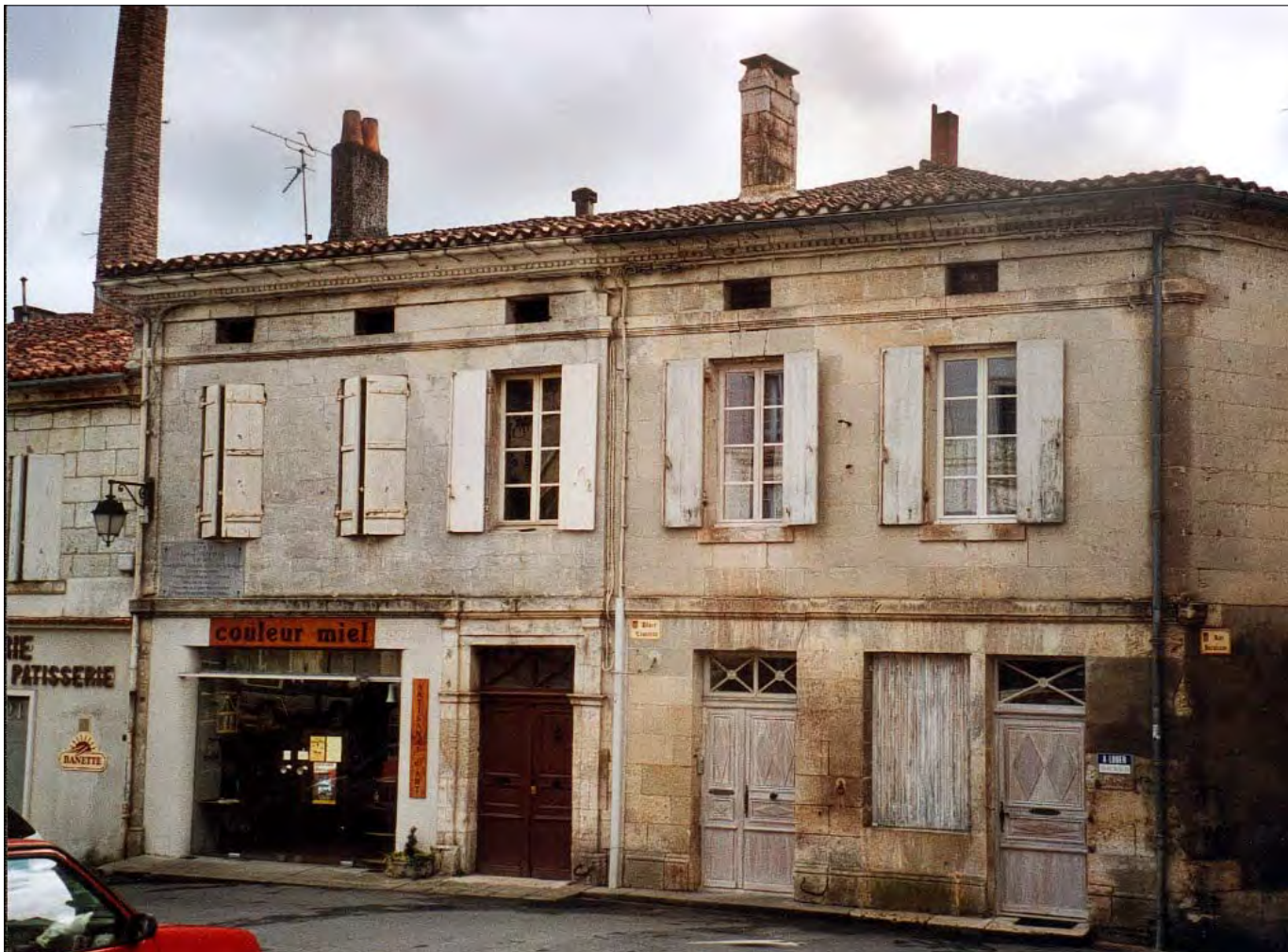
Parcelles 49 & 50, place Trarieux. Façades ordonnancées: corniches à denticules, bandeaux, pilastre central, encadrement de la porte d'entrée (parc.49).
