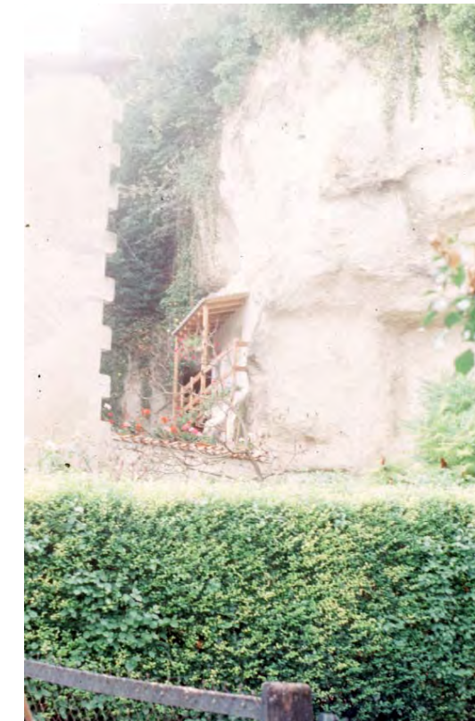
Parcelle 155, rue Saint Jean. Aménagement réalisé dans la roche.
