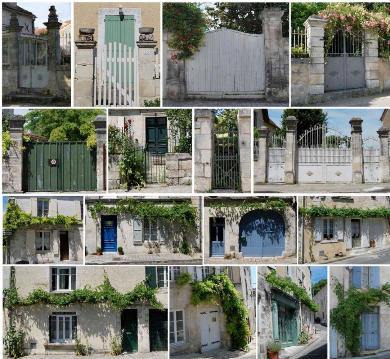
Illustration 38 : Repérage des ouvrages en pierre et des dispositifs végétaux
